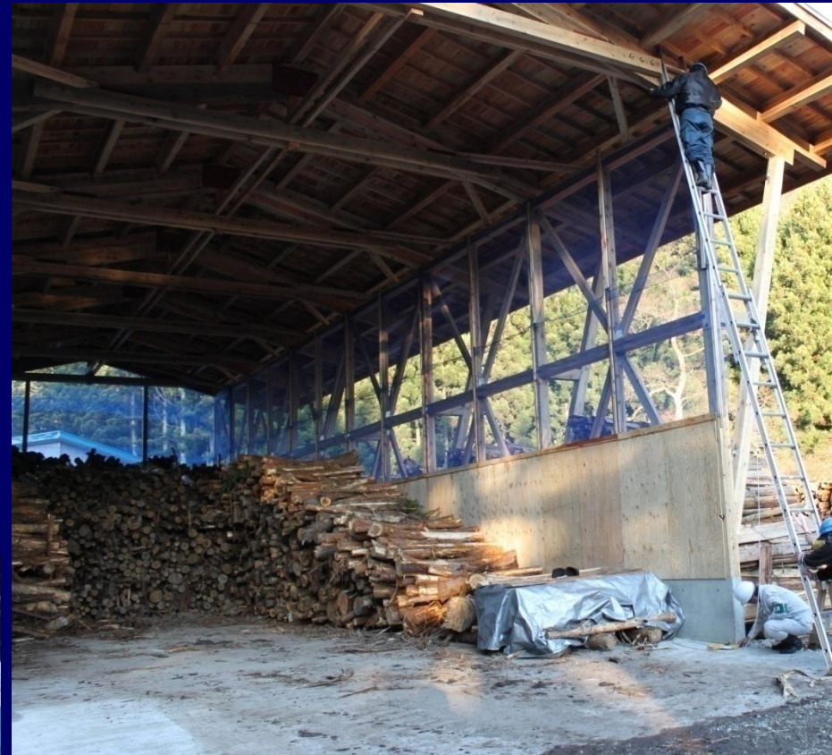
チップ貯留施設の新設
